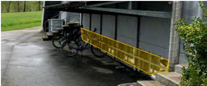
Vorsatzscheiben zur Abschirmung der Kellerfenster
