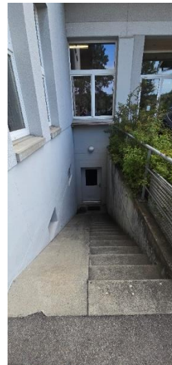
Ausseneingang mit Treppe
